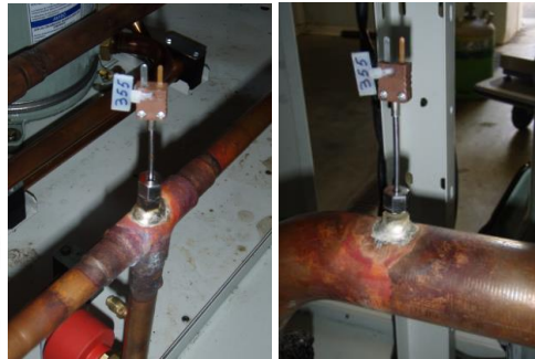
Figure 3 : Photos de traversées de parois et de leur mise en œuvre (source Trane)
