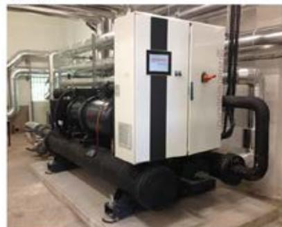
L'évaporateur de la pompe à chaleur produit l'eau réfrigérée (10°C) pour climatiser le data center. Le condenseur distribue l'énergie produite sur le réseau de chaleur (95°C)
